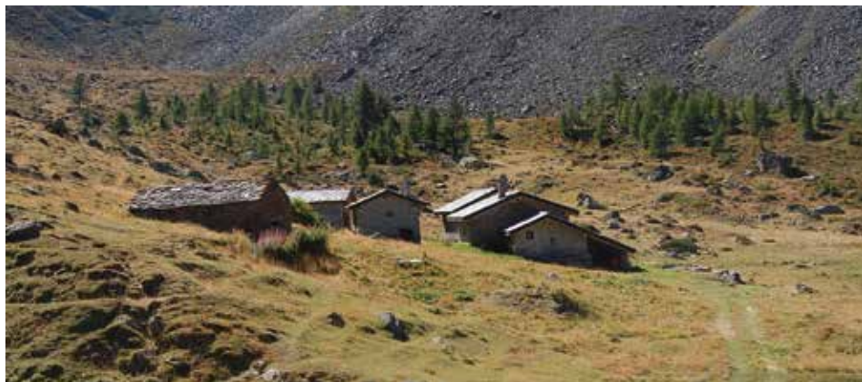
Fabbricati e pascoli all'alpeggio di Entrelor
